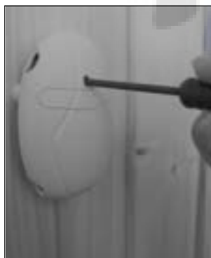
Figure 35. Reset button for overheating limiter obrazek 35. resetování teplotní ochrana
