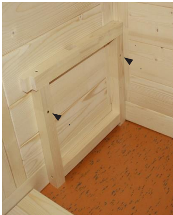
Obr. 32: Montáž podložky pod lavicu
