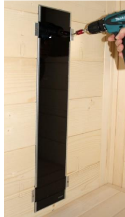
Obr. 41: Namontujte zadný žiarič (Infra-žiarič ECO 350)
