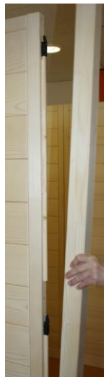
Obr. 9: Osadenie obidvoch predných rohových zasúvacích spôn s drážkou pre sklo
