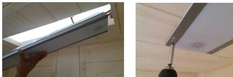
Obr. 50: Montáž farebnej lampy
