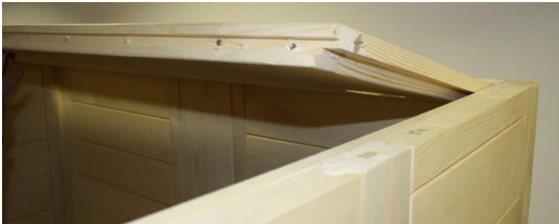
Obr. 18: Vloženie predného strešného dielu
