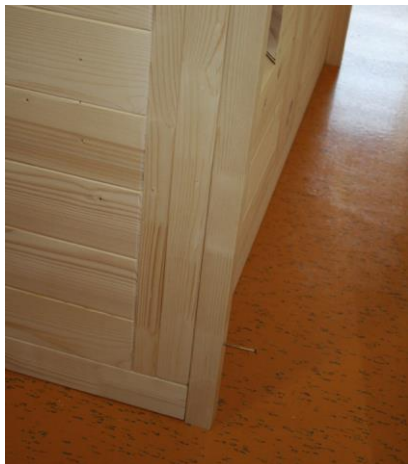
Obr. 52: Montáž dištančných líšt na zadnej stene kabíny
