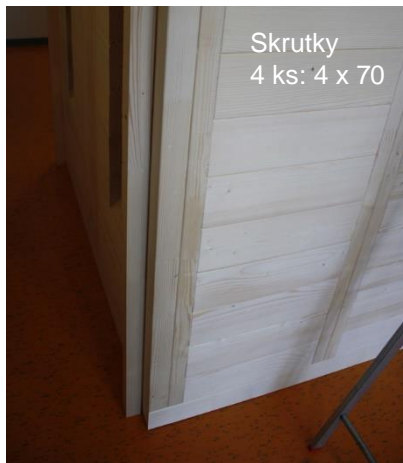
Obr. 52: Montáž dištančných líšt na zadnej stene kabíny
