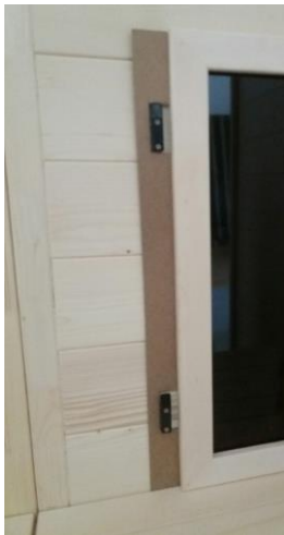
Obr. 53: Montáž opierky hlavy
