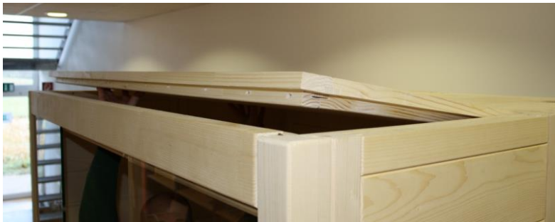
Obr. 18: Vloženie predného strešného dielu
