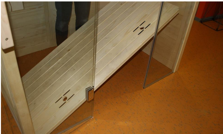
Obr. 28: Vloženie spodnej časti kabíny
