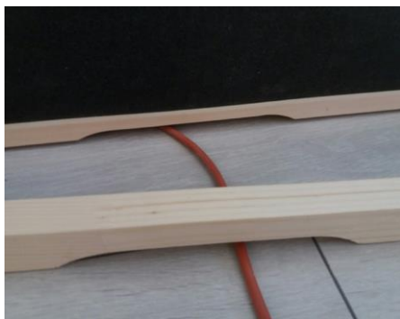
Obr. 35: Osadenie zošikmenej lišty pre IR-platničku VitaMy
