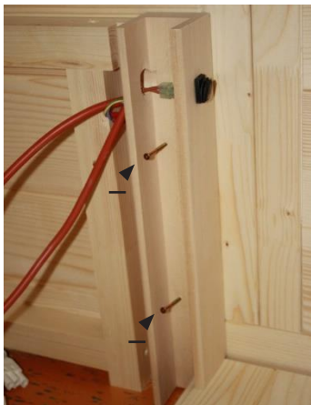
Obr. 33: Montáž U-proflou pre platničku
