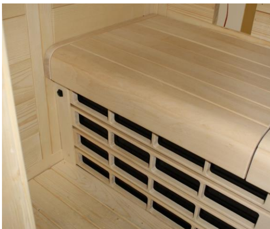
Obr. 40: Vloženie sedacej časti lavice
