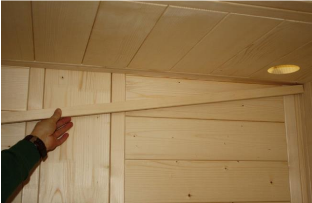
Obr. 37: Montáž LED krycej lišty
