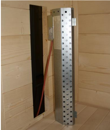
Obr. 41: Namontujte zadný žiarič (Infra-žiarič ECO 350)
