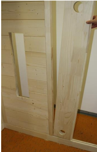
Obr. 7: Namontovaná zadná stena
