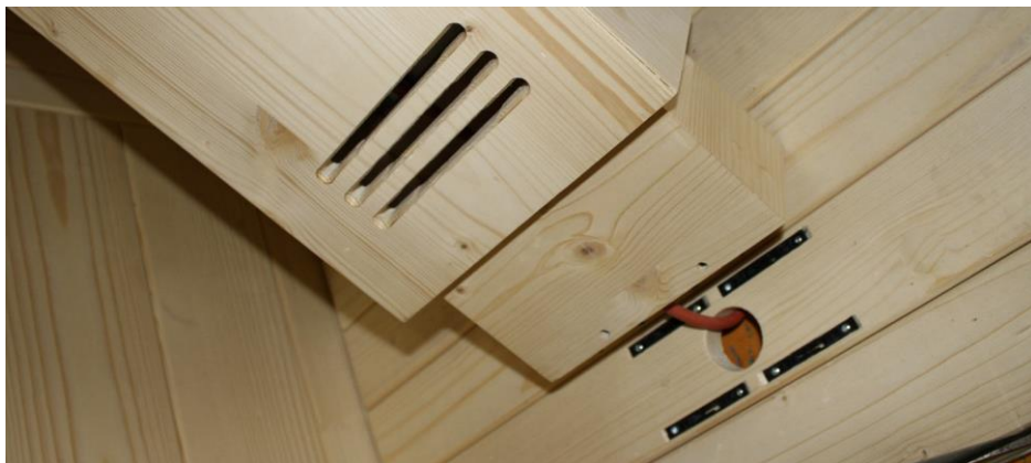
Obr. 29: Ukotvenie predného žiariča
