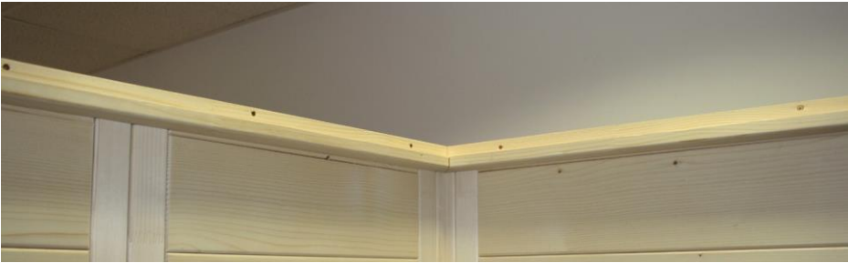
Obr. 17: Vloženie strešného dielu spolu s výrezom pre odvetranie
