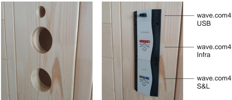
Obr. 49: Montáž ovládacej časti
