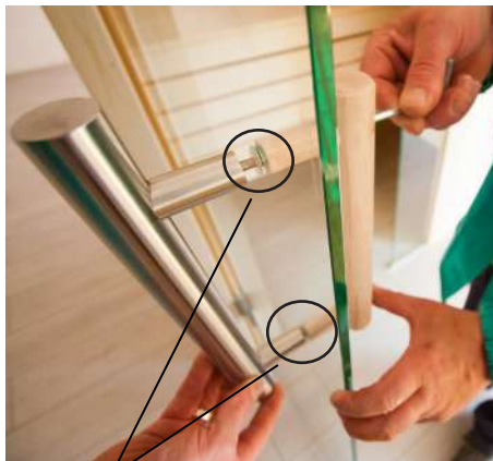
Přiložení plastových příloček u rukojetí z nerezové oceli
